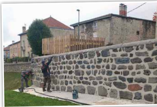
Sur la Place Centrale, des murs en pierres ont été confortés et jointés par l'entreprise SAVEL.
